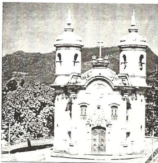
Foto 8: Fachada da Igreja de S. Francisco, Ouro Preto.
